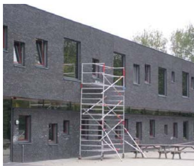
► Schilders schaften, de steiger is opklimbaar, niet voorzien van kantplanken en de verf staat er bovenop. En elk moment kan de schoolbel voor de pauze gaan....
