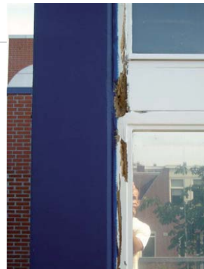
▲ Aparte werkvolgorde: eerst schilderen en daarna houtherstel.
